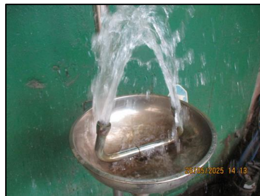
ภาพที่ 2.34 ฝักบัวฉุกเฉินภายในพื้นที่โครงการ
