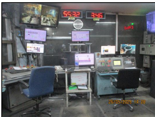
ภาพที่ 2.23 ห้องควบคุมที่ติดตั้งระบบปรับอากาศและวัสดุดูดซับเสียงในสายการผลิต
