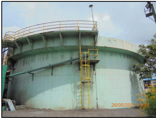
ภาพที่ 2.19 บ่อตกตะกอน (Clarifier)
