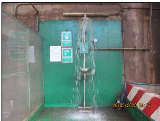
ภาพที่ 2.34 ฝักบัวฉุกเฉินภายในพื้นที่โครงการ
