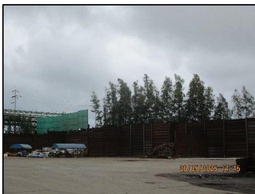
ภาพที่ 2.6 ลานคอนกรีตที่มีผนังกันเป็นช่อง สำหรับกองเก็บวัตถุดิบก่อนเข้าสู่เตาหลอม
