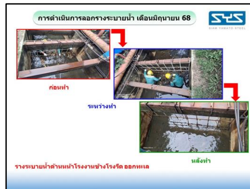
ภาพที่ 2.14 การขุดลอกทรายระบายน้ำภายในโครงการ
