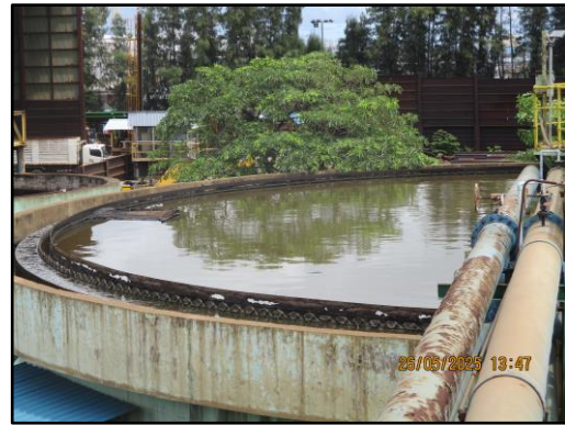
ภาพที่ 2.19 บ่อตกตะกอน (Clarifier)
