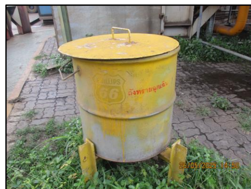
ภาพที่ 2.15 ถังทรายที่ใช้ดูดซับสารเคมีภายในโครงการ กรณีสารเคมีหกหรือรั่วไหล
