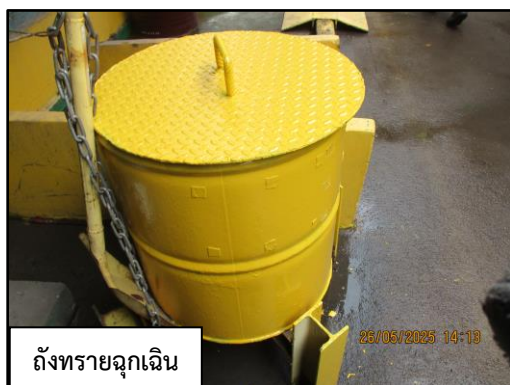
ภาพที่ 2.15 ถังทรายที่ใช้ดูดซับสารเคมีภายในโครงการ กรณีสารเคมีหกหรือรั่วไหล
